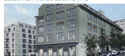
Lausanne, Avenue de Sévelin 15
