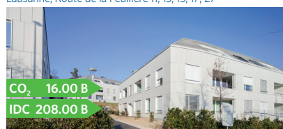
Lausanne, Route de la Feuillère 11, 13, 15, 17, 27 ①
