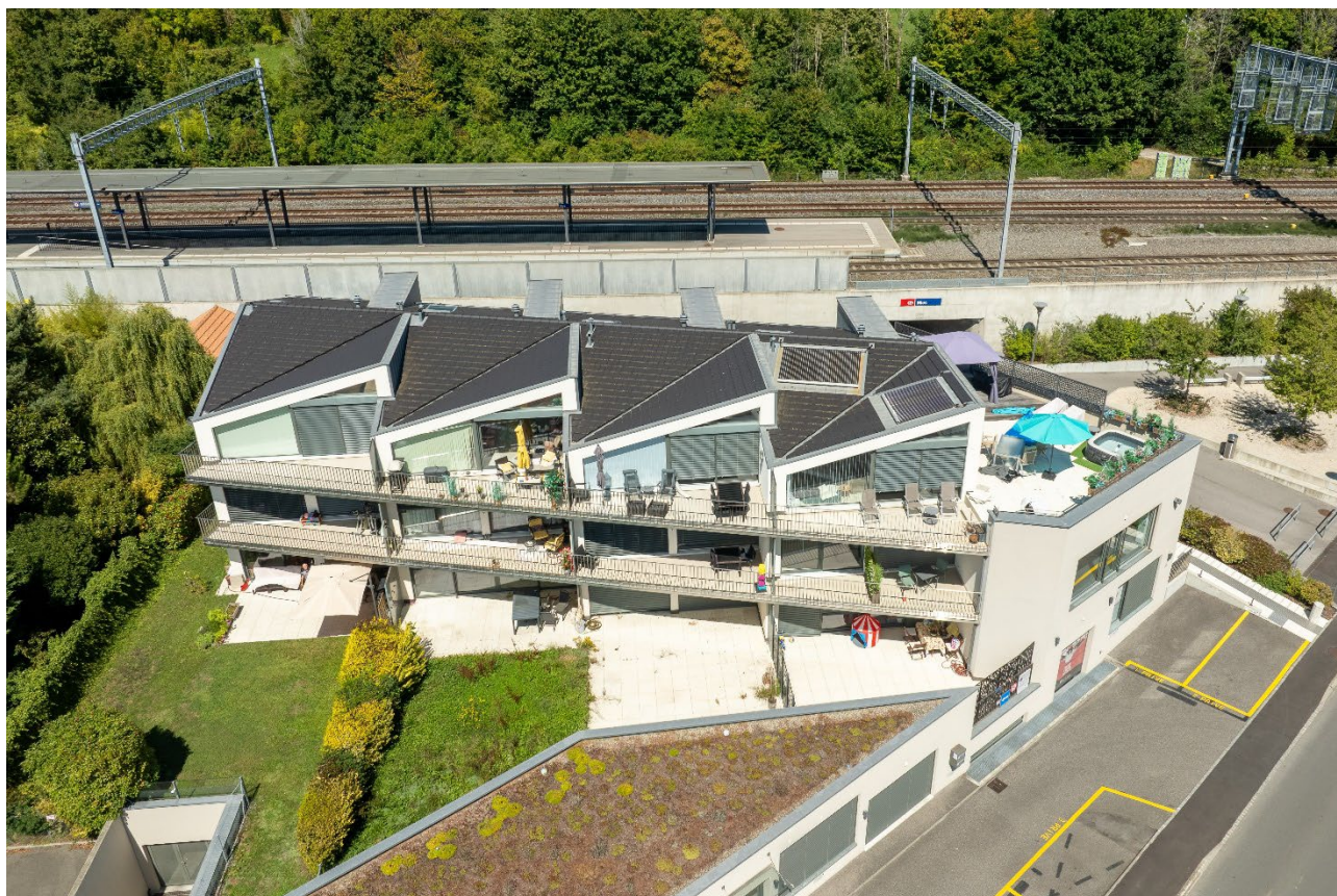
Mies (VD) - Route de la Gare 16-16A
