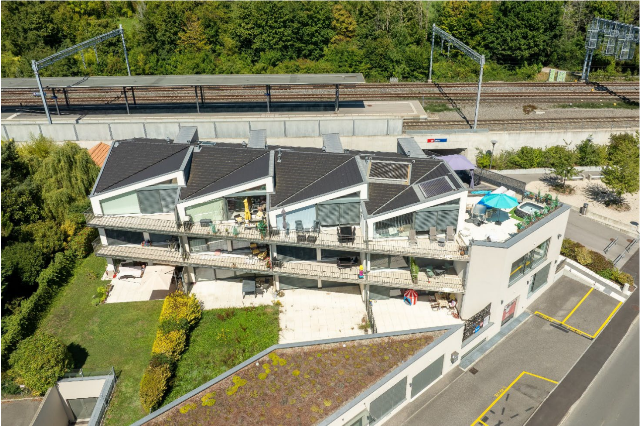
Mies (VD) - Route de la Gare 16-16A
