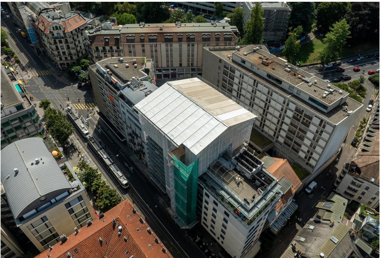
Genf – Rue de la Terrassière 26 (im Umbau)
