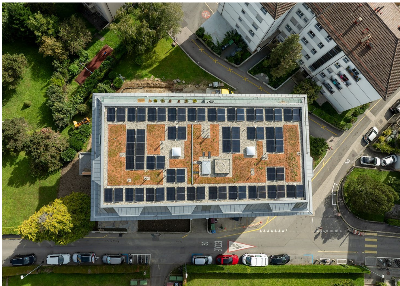
Lausanne (VD) – Chemin de Chandieu 22
