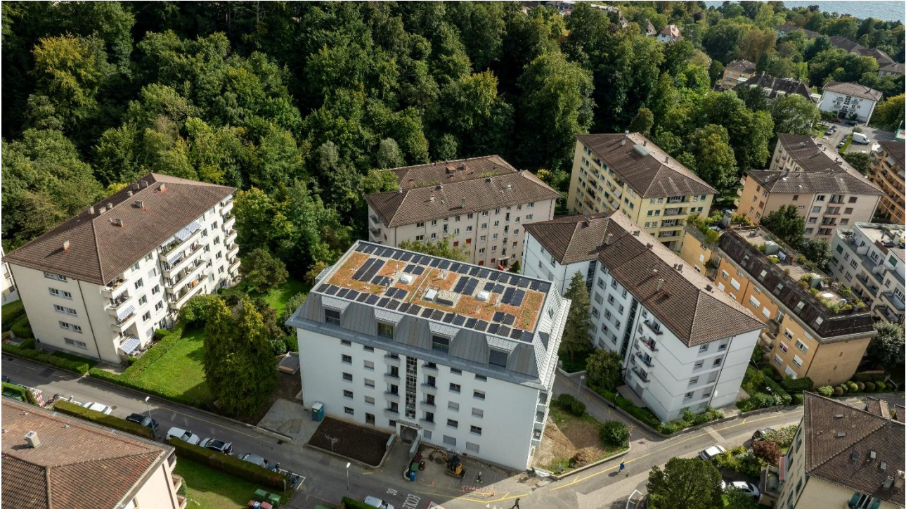
Lausanne – Chemin de Chandieu 22
