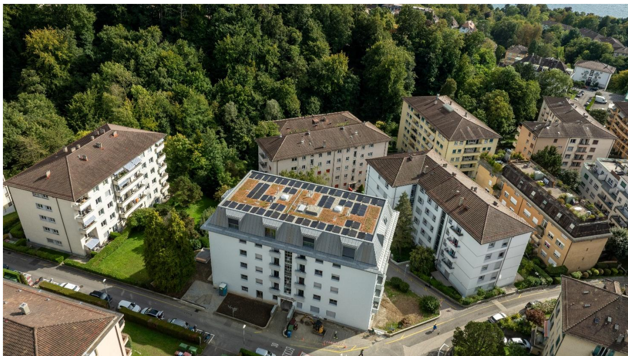
Lausanne – Chemin de Chandieu 22
